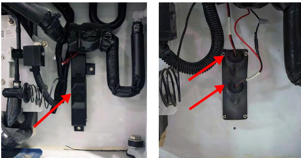
Figure 7.20 sondes soufflage - Assemblage du couvercle et sondes
