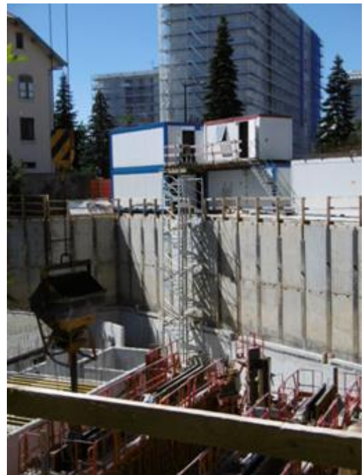
Accès en fond de fouille
