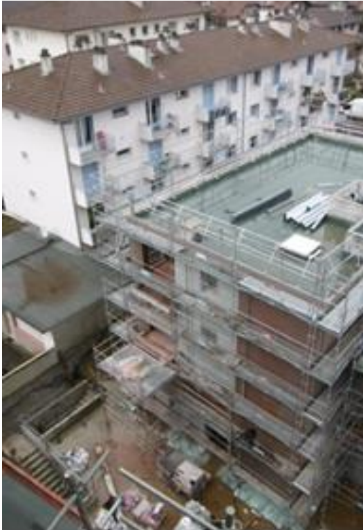
Echafaudages périphériques intégrant les protections en toiture
