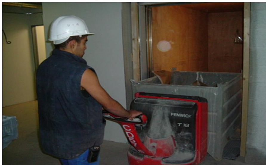
Evacuation des déchets
