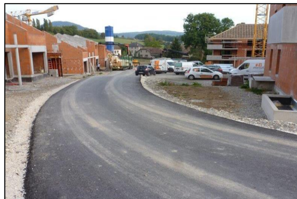
Création d'accès chantier
