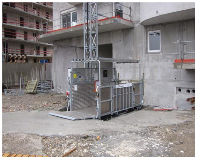
Lift approvisionnement à plat (bétonné)
